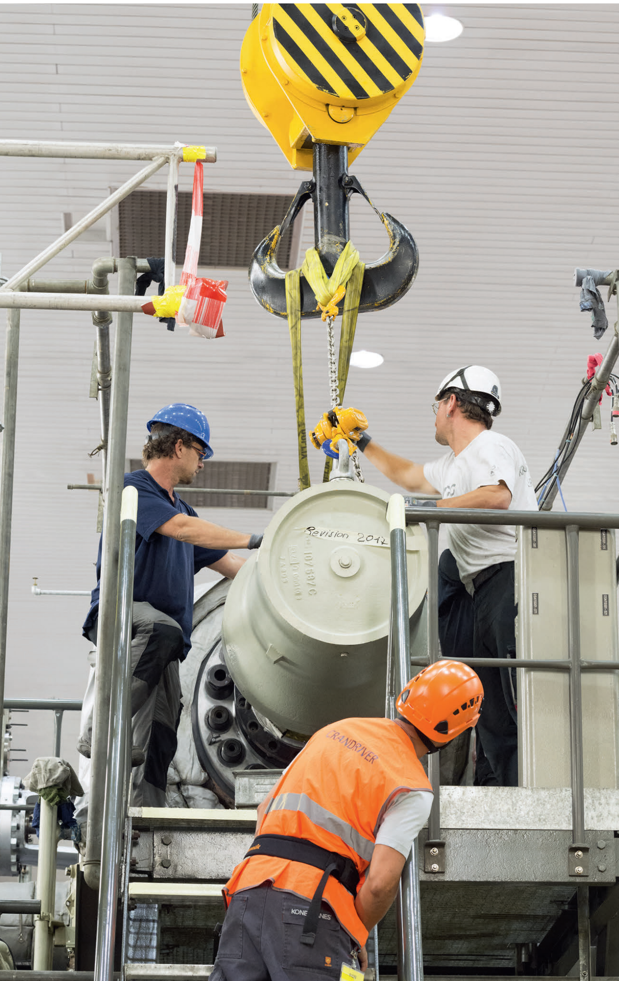
Am Turbosatz Arbeiten an einem Turbinen-Schnellschluss- ventil
