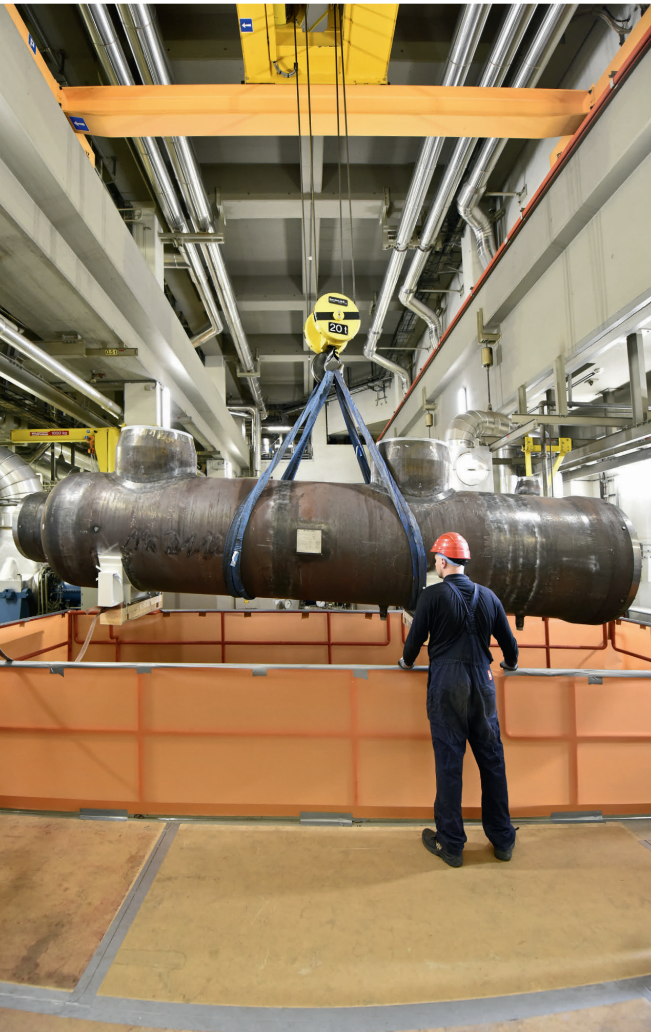
Transport im Maschinenhaus Austausch eines Zwischenüberhitzer- Kondensatkühlers
