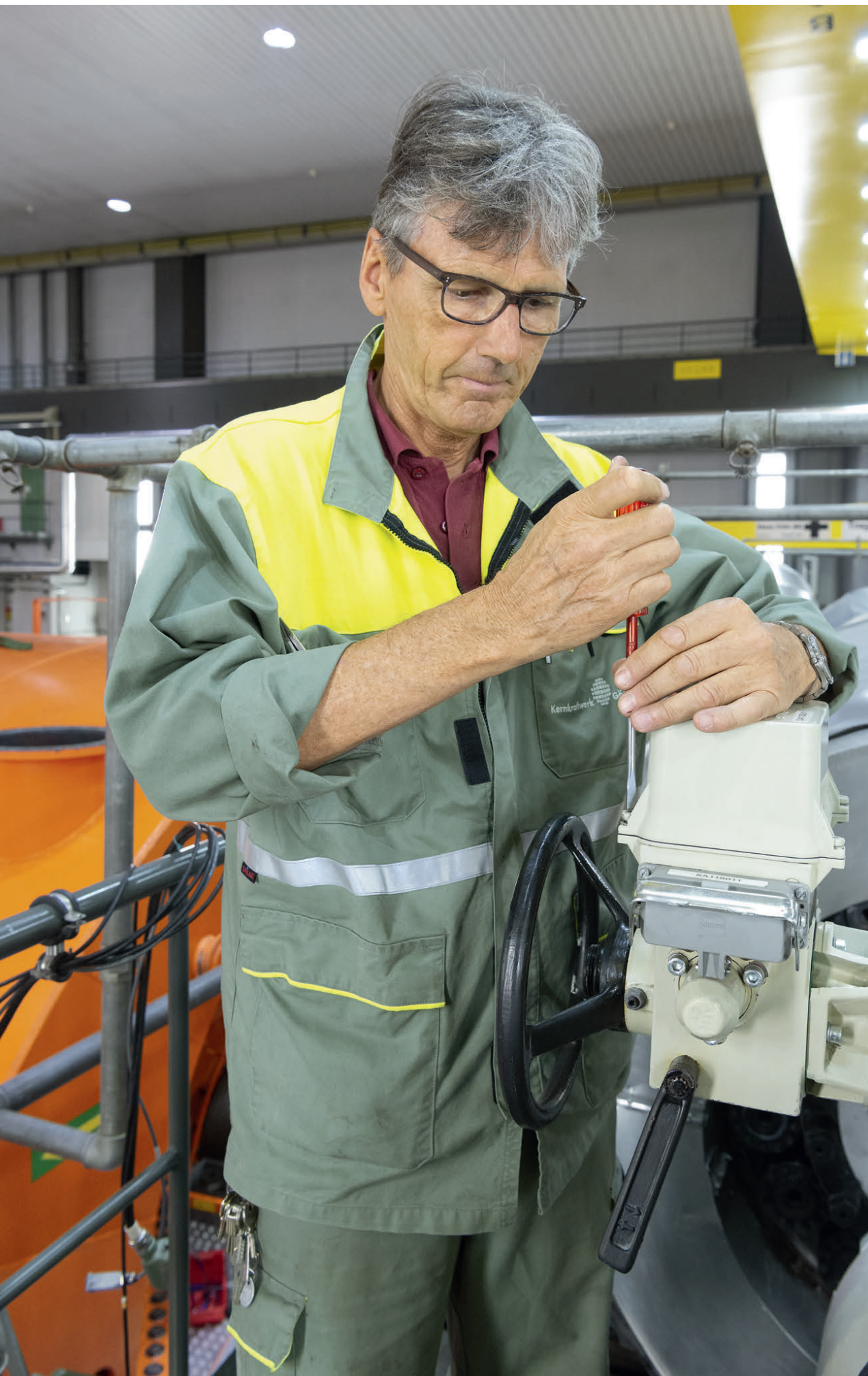
Im Maschinenhaus Einstellarbeiten an einem Stellantrieb
