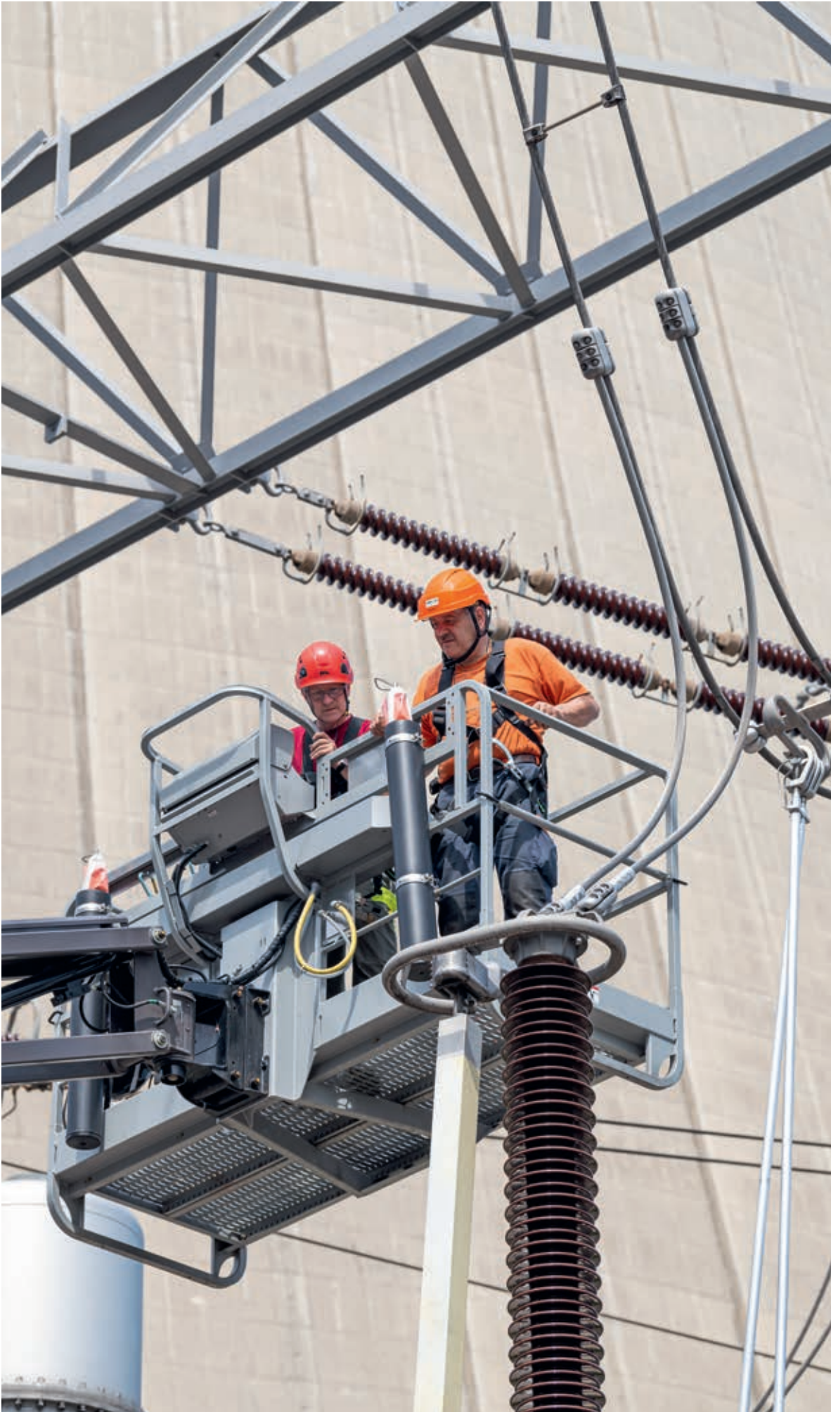
Am Hochspannungsseil Überprüfung auf Festigkeit, Korrosion und Abbrand
