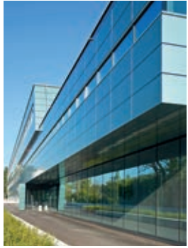
Centralschweizerische Kraftwerke AG (CKW), Luzern
