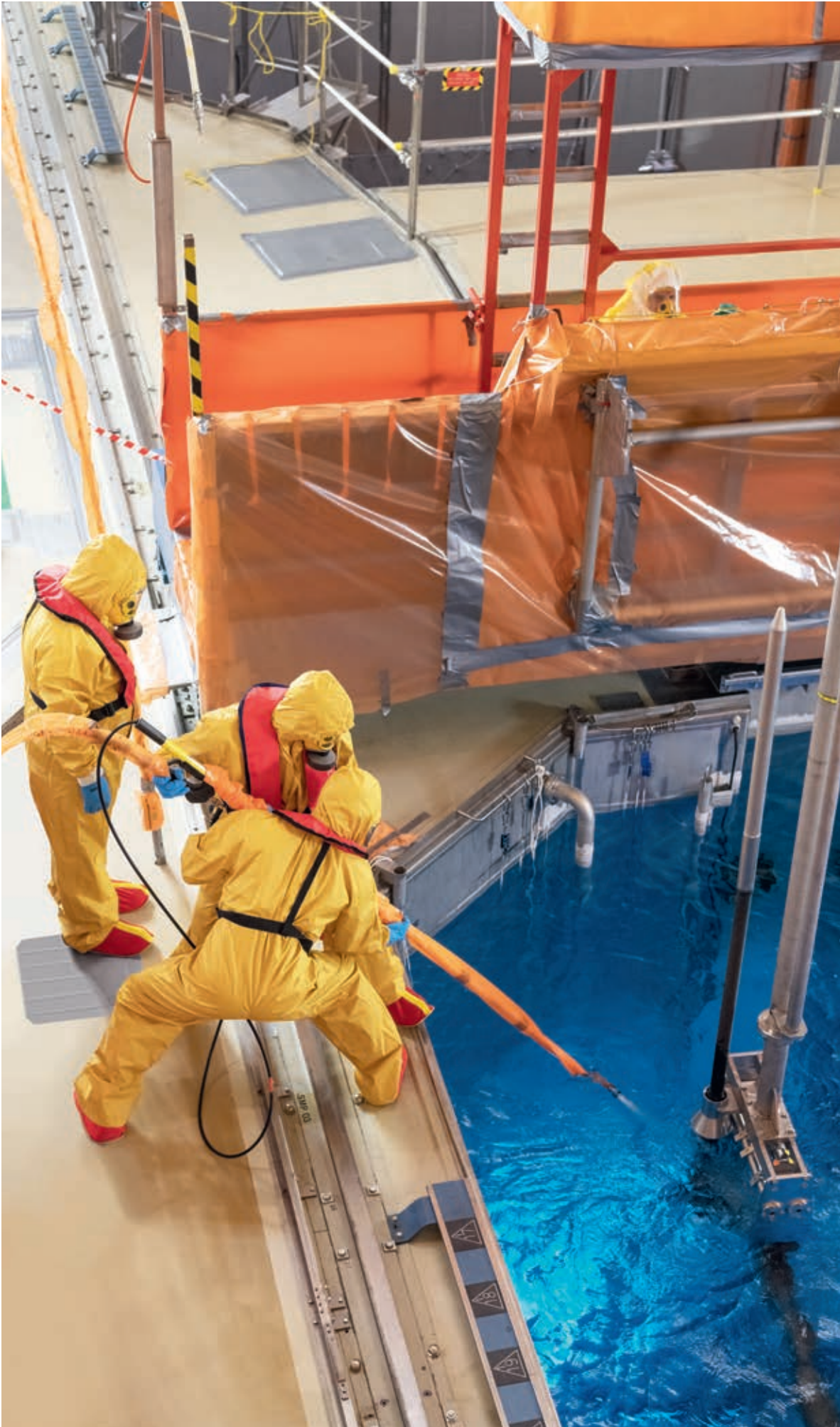
Am Brennelement- lagerbecken Dekontamination der Jobbleche einer Instrumentierungslanze
