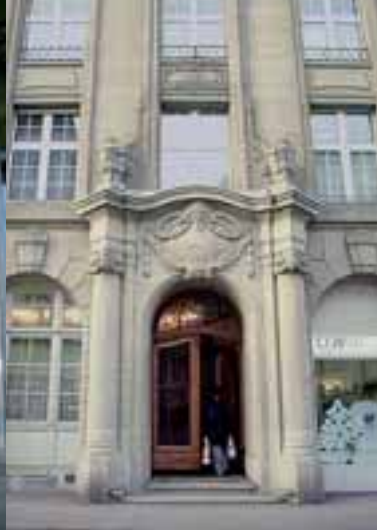
Centralschweizerische Kraftwerke AG (CKW), Luzern
