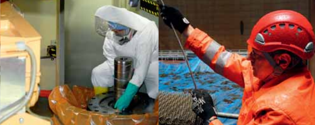
Jahresrevision 2008 Umfangreiche Instandhaltungsarbeiten
