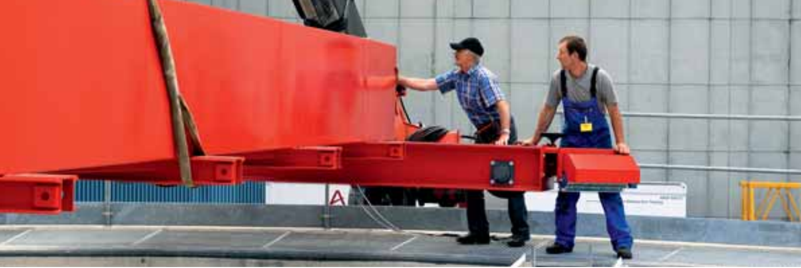
Entkarbonierungsanlage Der revidierte Raumer wird montiert.
