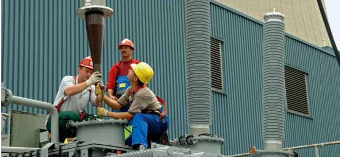
**Fremdeinspeisetransformator** Montage der Durchführung zum neuen 220-kV-Transformator
