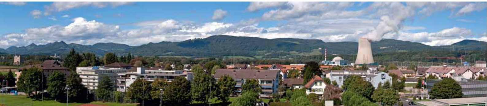
Das Kernkraftwerk Gösgen Blick auf die Standortgemeinde Däniken
