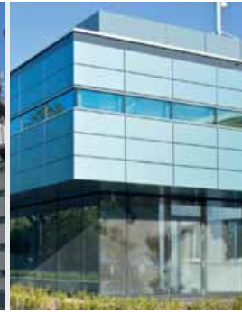
Centralschweizerische Kraftwerke AG (CKW), Luzern
