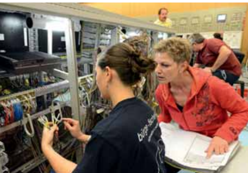
Jahresrevision 2013 Unterhalts- und Instandhaltungsarbeiten
