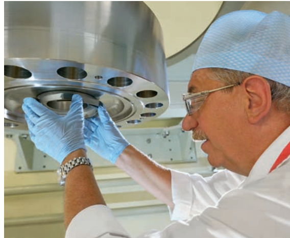
Im Ringraum Druckdeckelmontage an einer Hochdruckförderpumpe
