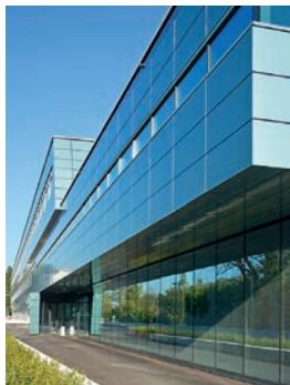
Centralschweizerische Kraftwerke AG (CKW), Luzern
