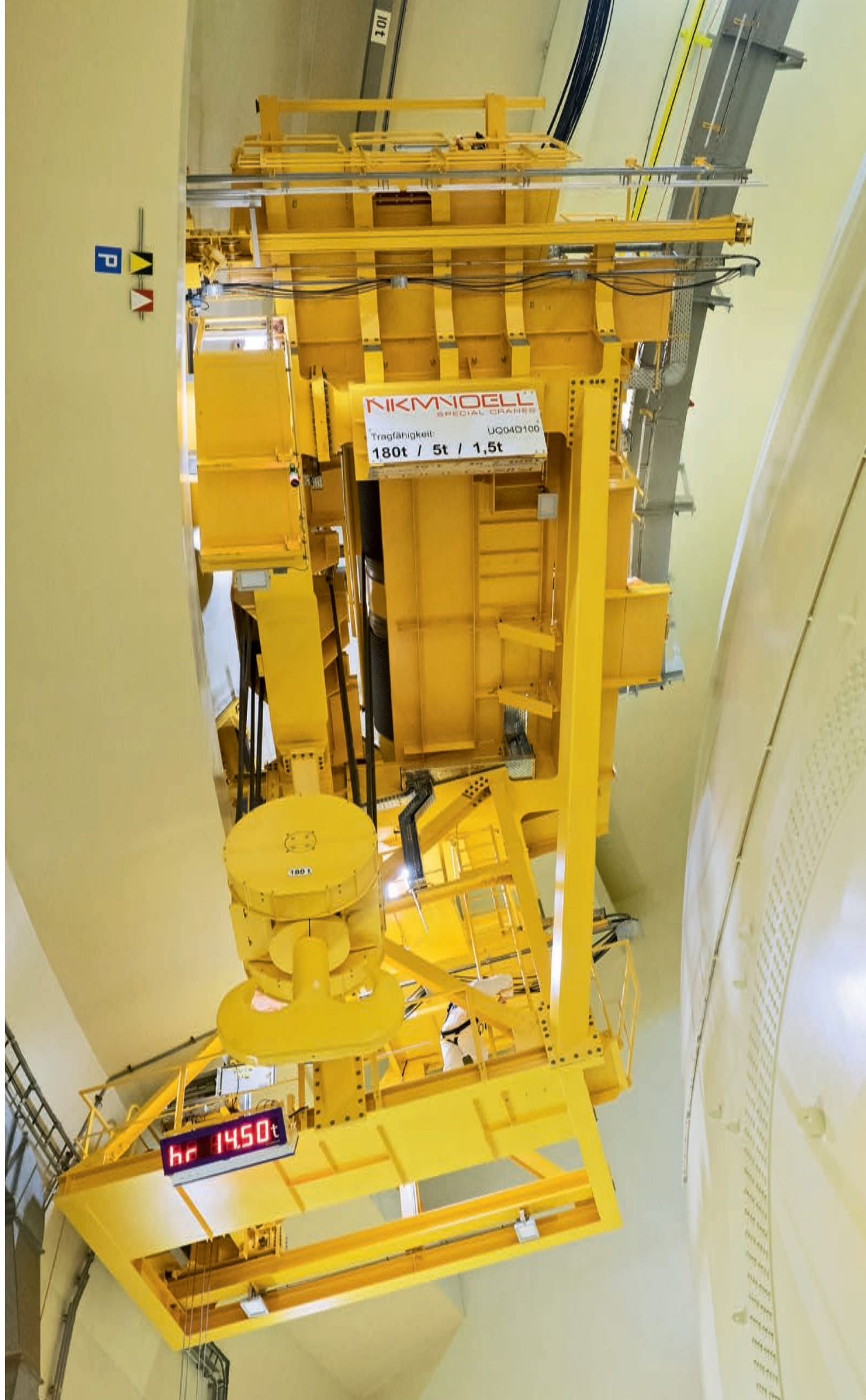
Im Ringraum des Reaktorgebäudes Endmontage des Konsolladekrans
