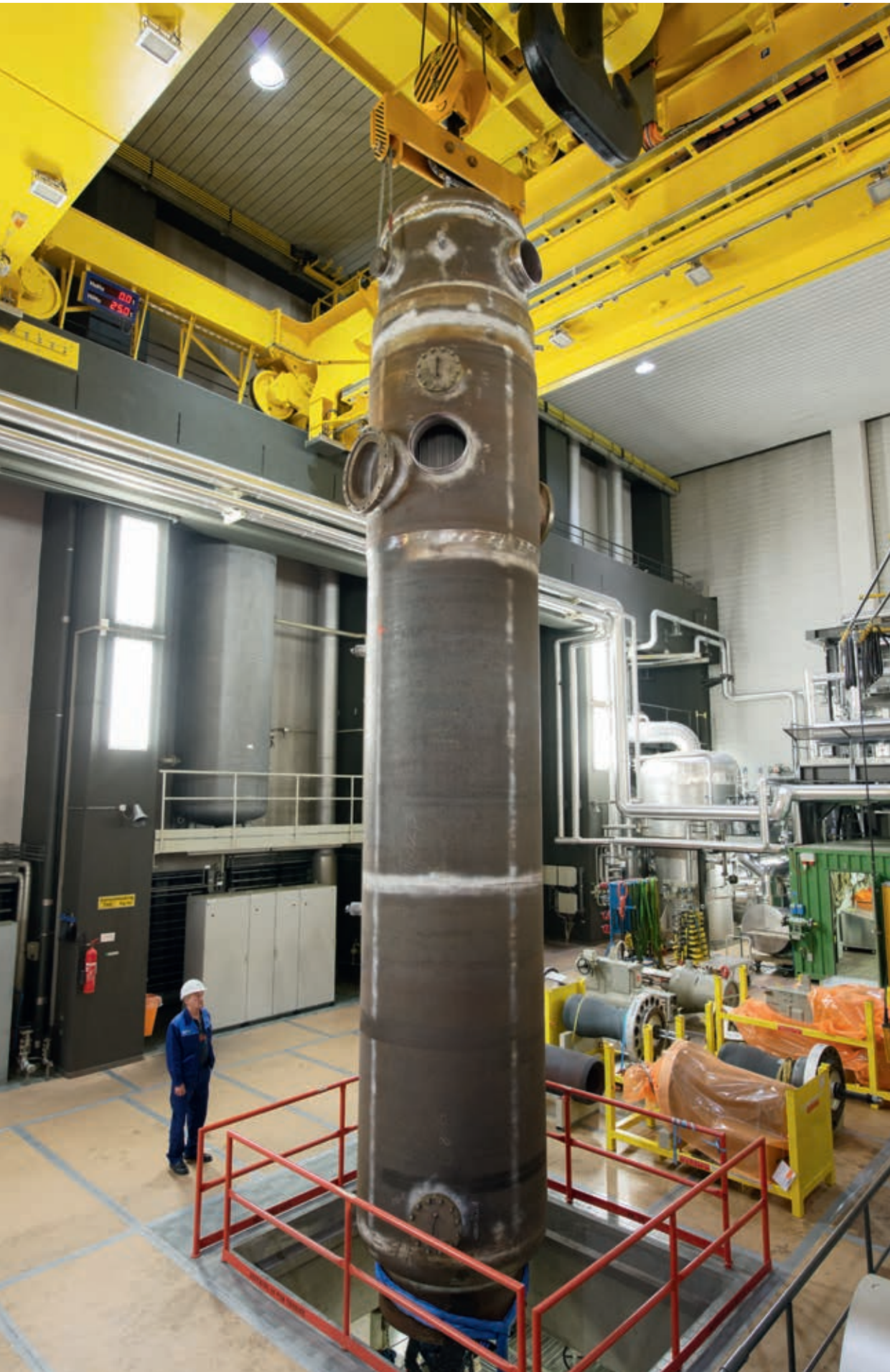
Im Maschinenhaus Ersatz eines Niederdruck- Vorwärmers
