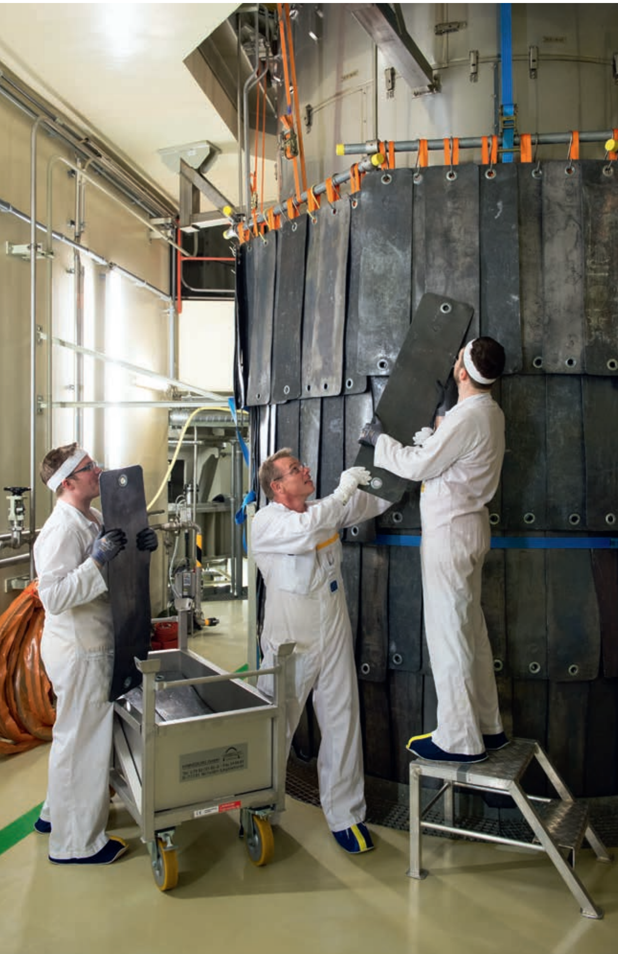
Am Druckhalter Anbringung einer Bleibschirmung
