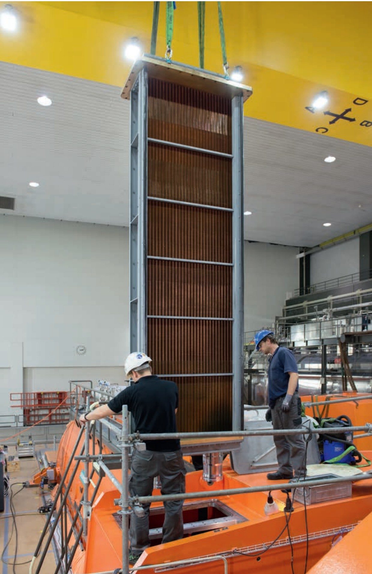
Am Generator Einbau eines Wasserstoffkühlers
