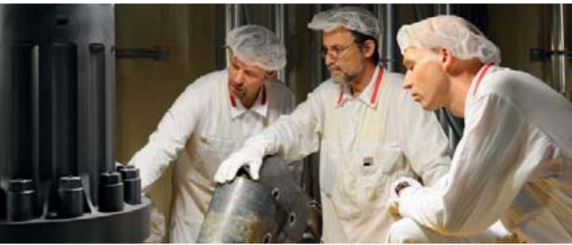
Jahresrevision 2012 Unterhalts- und Instandhaltungsarbeiten
