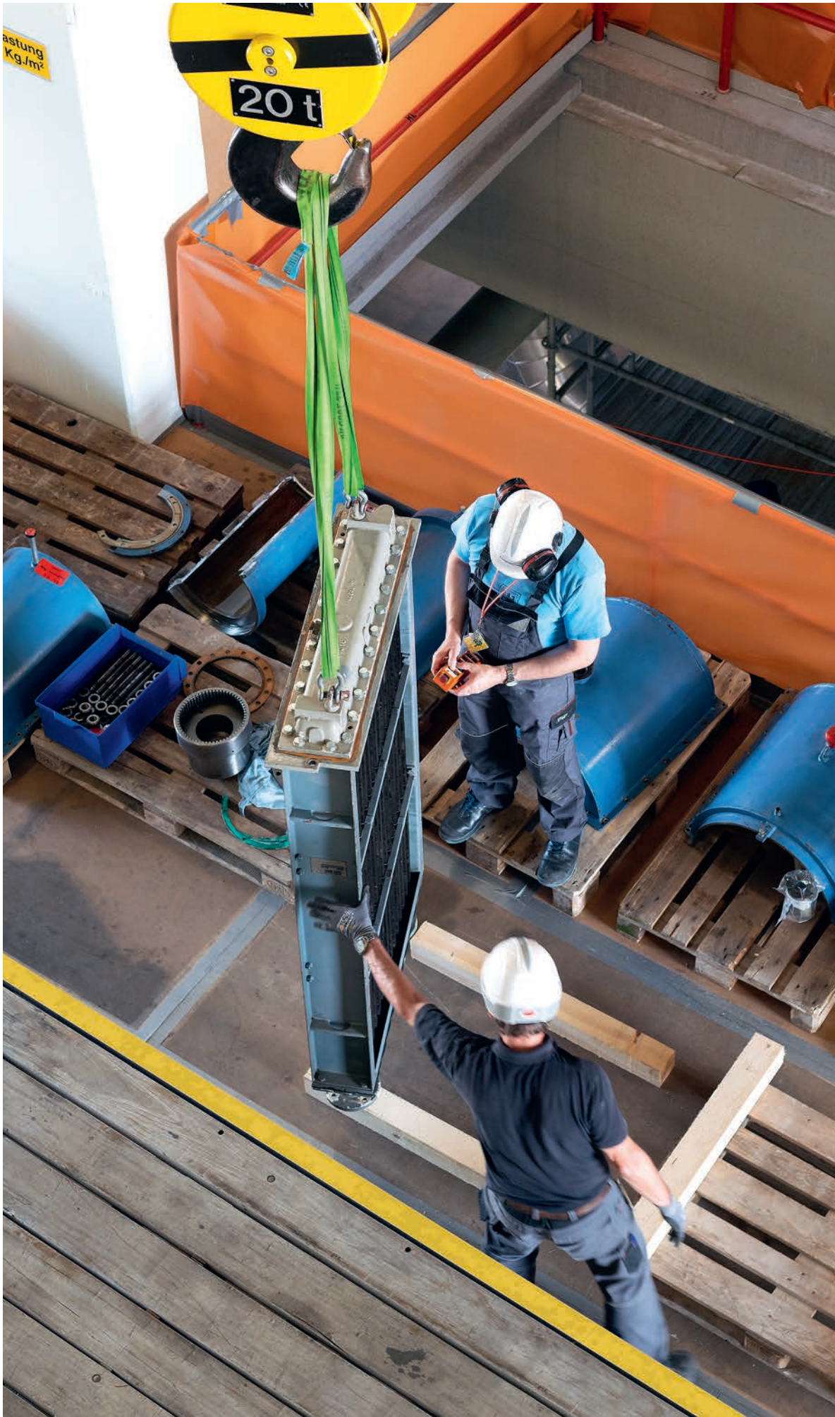
Im Maschinenhaus Ausbau des Luft-Wasser- Kühlers eines Hauptspeise- wasser-Pumpenmotors
