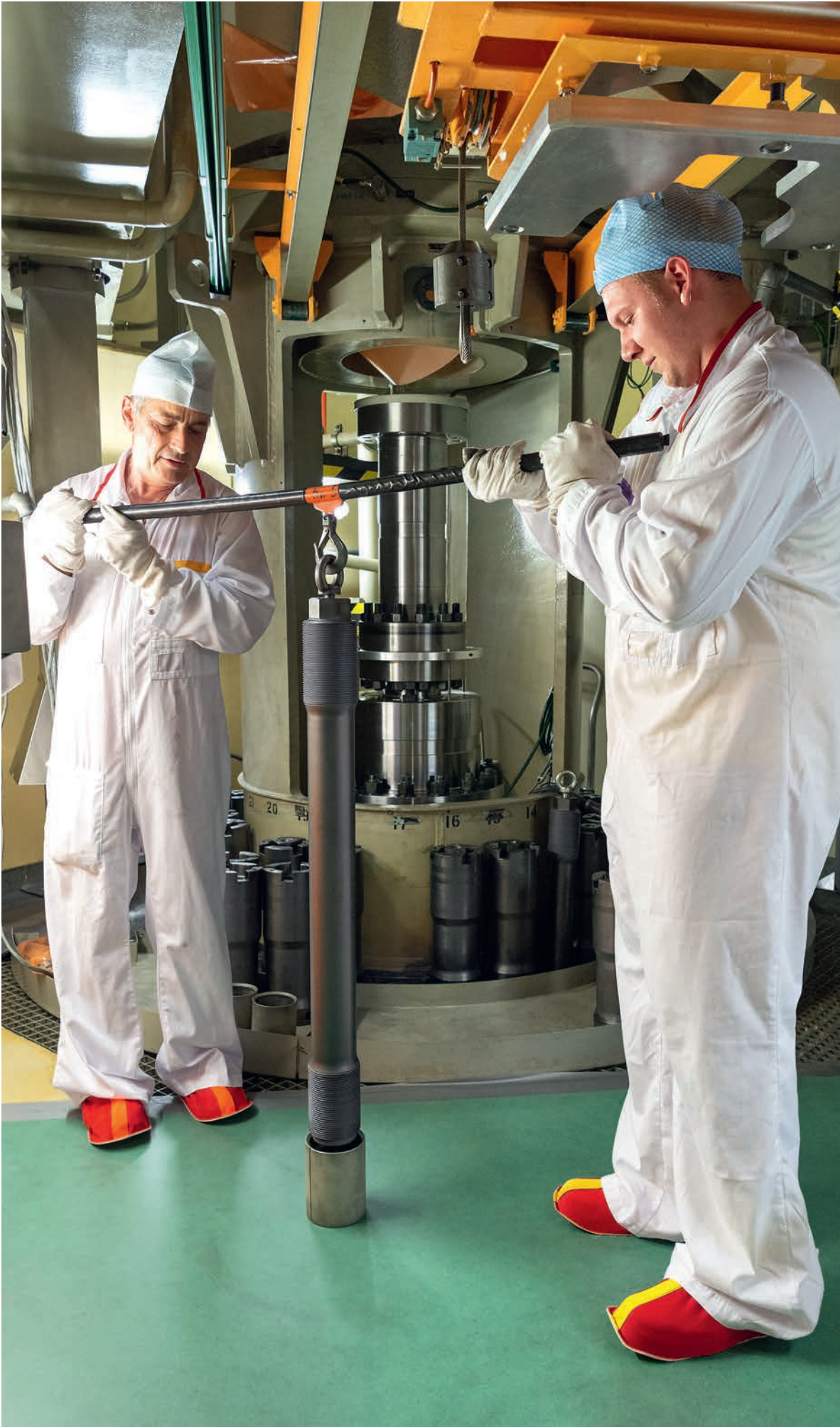
Vorbereitung einer Wirbelstromprüfung Ausbau der Haupt- verbindungsschrauben einer Hauptkühlmittel- pumpe
