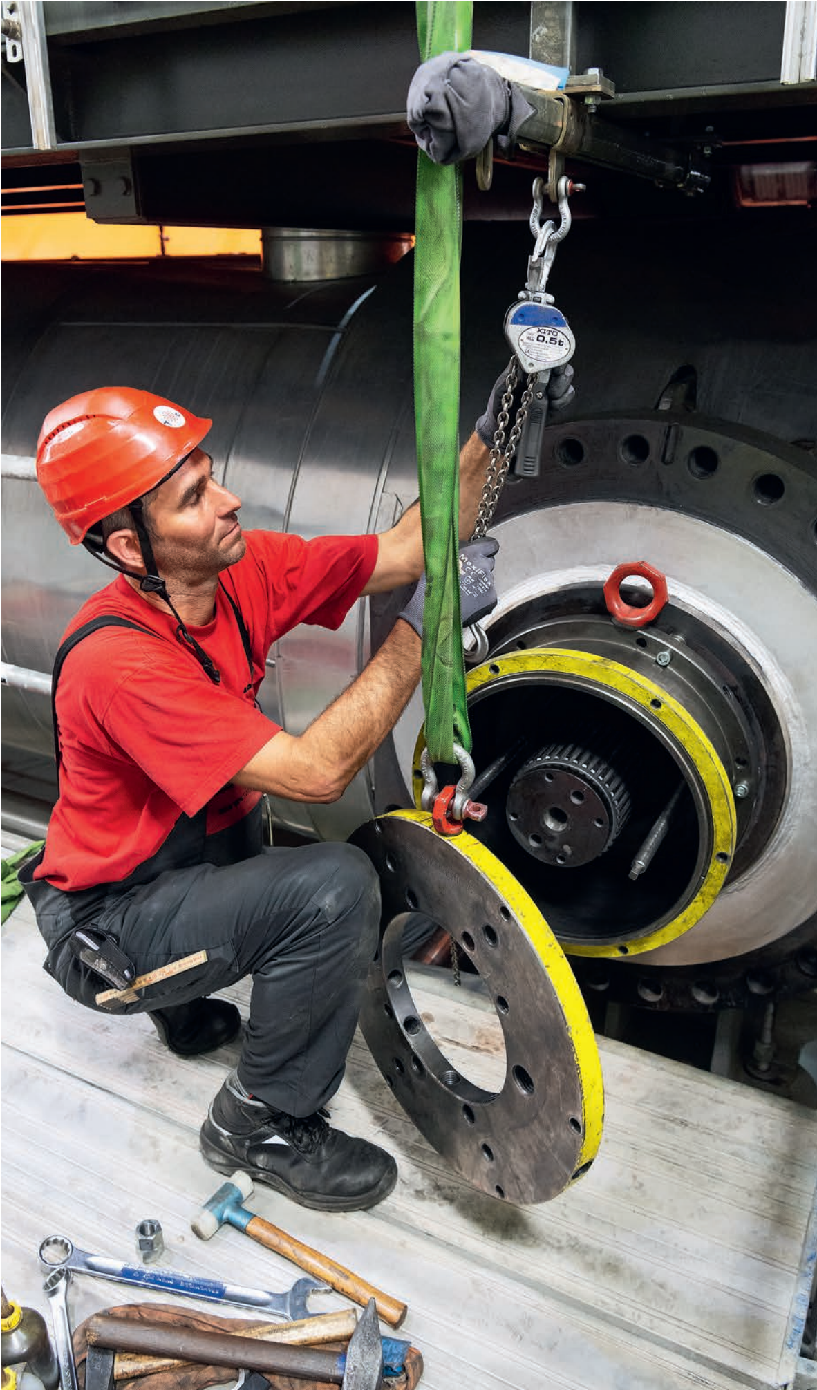
Im Maschinenhaus Arbeiten an der Abfangstellklappe der Dampfturbine
