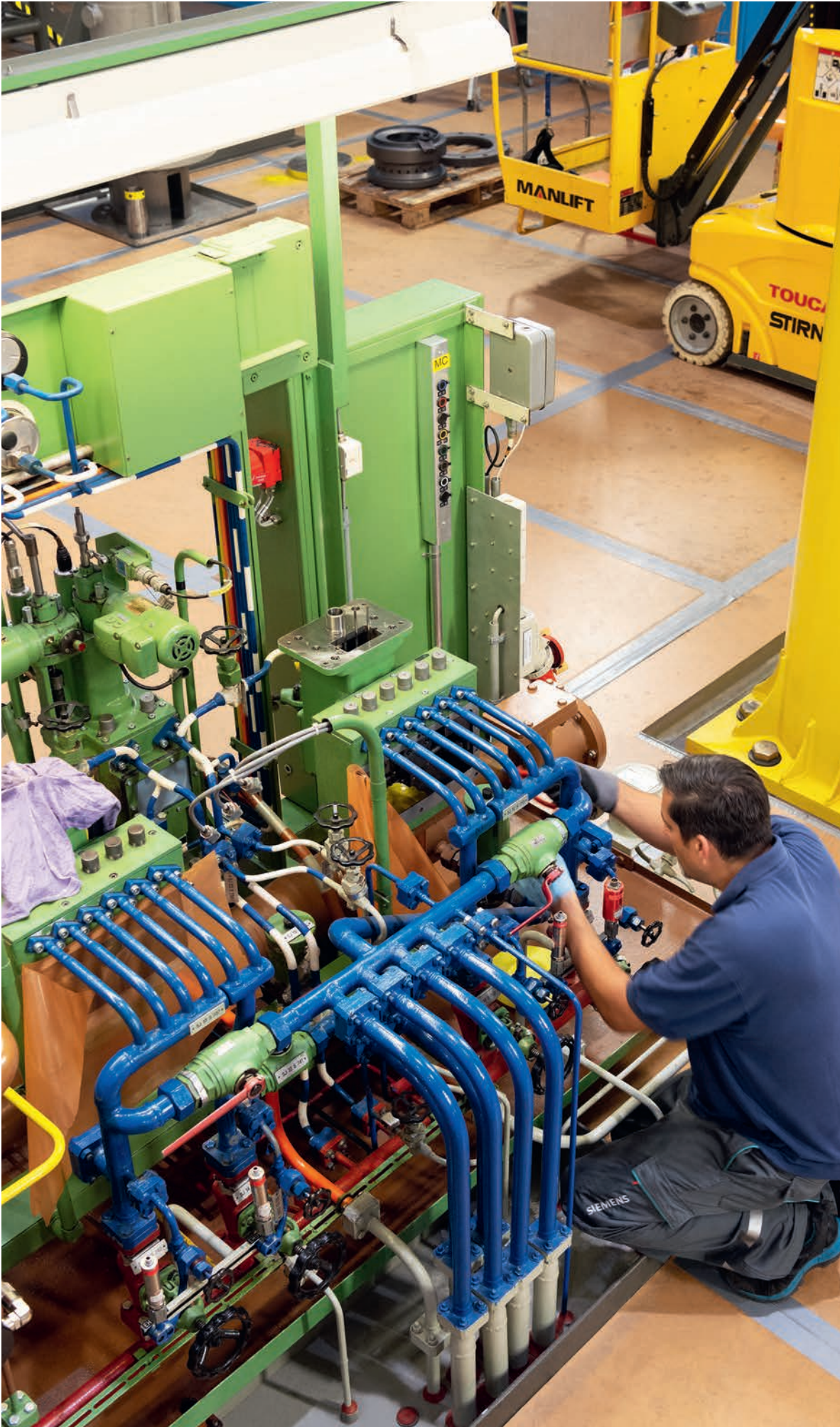
Im Maschinenhaus Umbauarbeiten am elektrohydraulischen Umformer der Dampf- turbinenregelung
