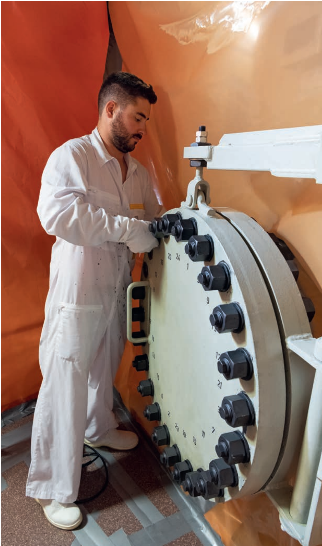
Inneninspektion Öffnen eines Mannlochs für den Einstieg in einen Druckspeicher
