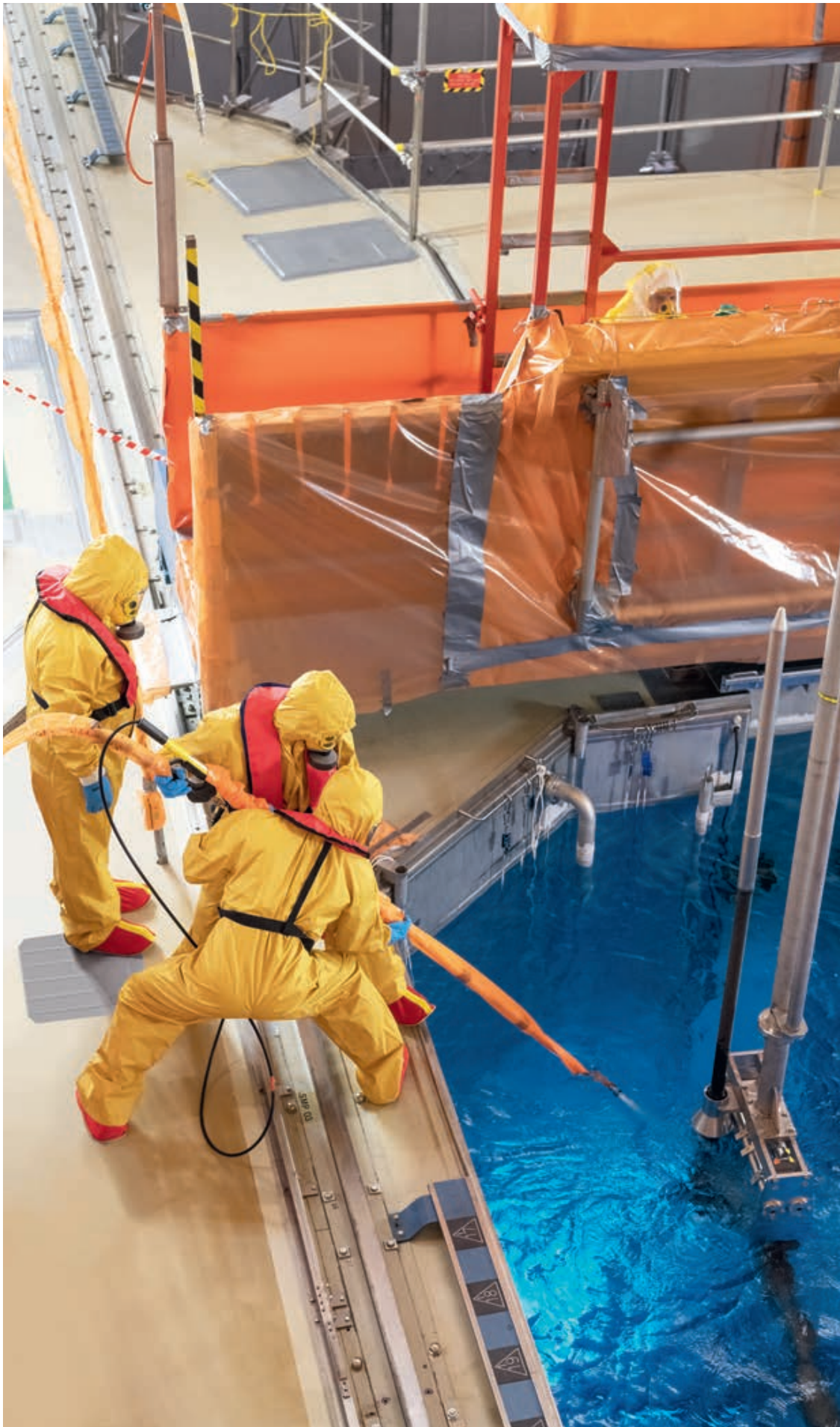
Am Brennelement- lagerbecken Dekontamination der Jodbleche einer Instrumentierungslanze
