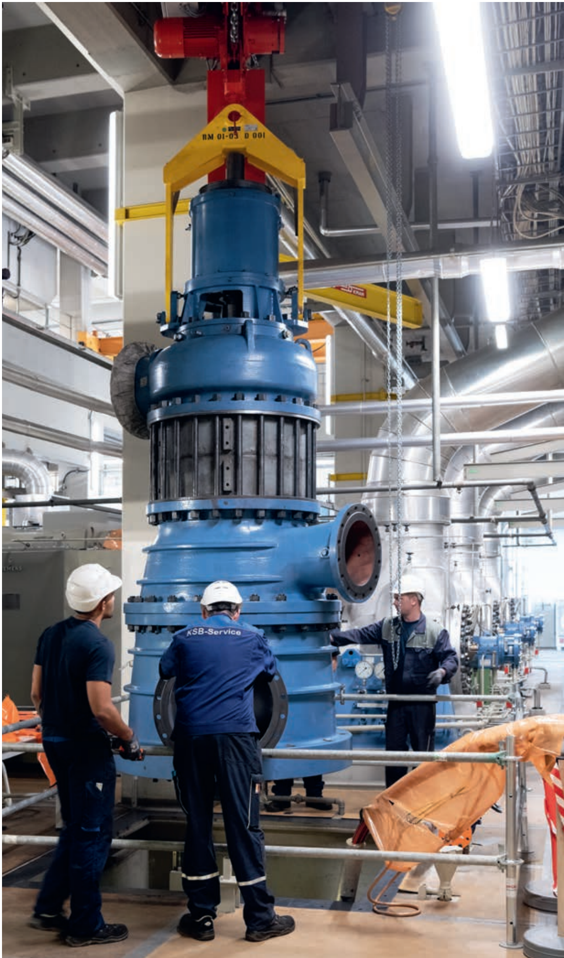
Im Maschinenhaus Absenken der revidierten Hauptkondensatpumpe an ihren Standort
