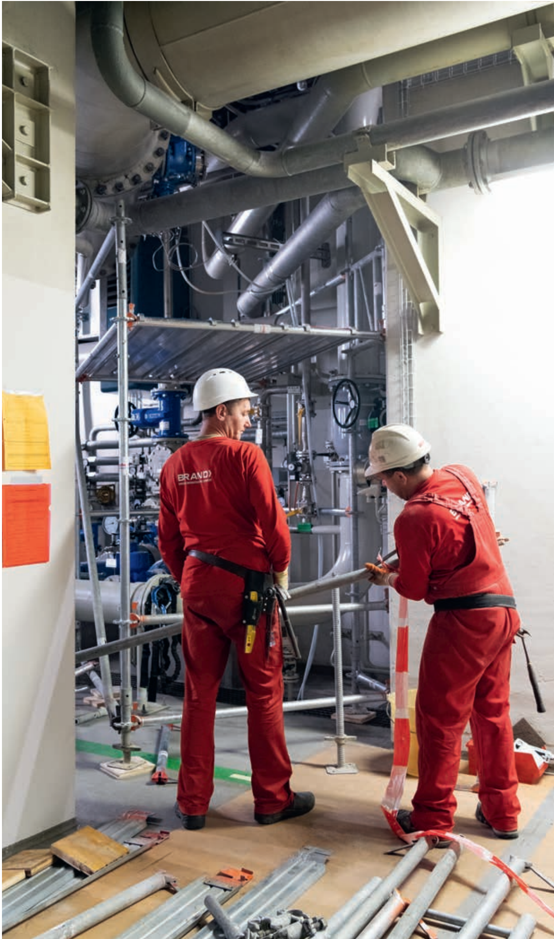
Im Maschinenhaus Gerüstbau bei der neuen Kondensat- aufbereitungsanlage
